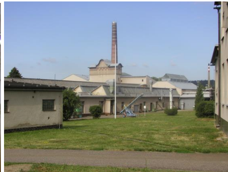
Pohled na dílnu ze dvora, kde je ještě část s původním zastřešením
