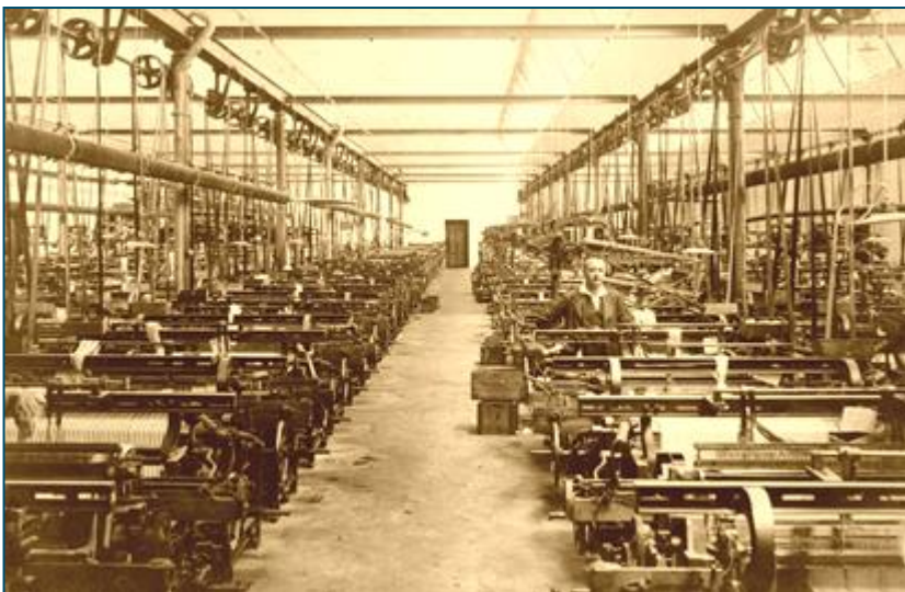
Pohon tkalcovských stavů byl zajištěn pomocí transmisí
