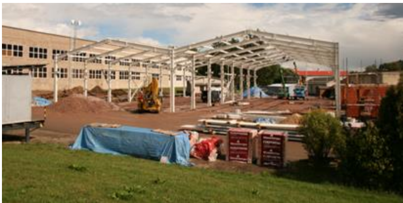
Výstavba nové montážní haly v září 2007
