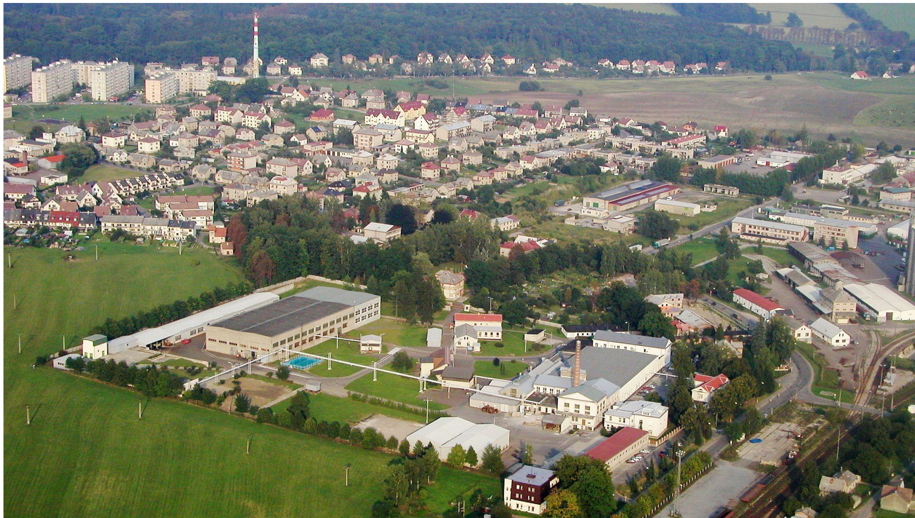
Letecký pohled na areál továrny v r. 2002
