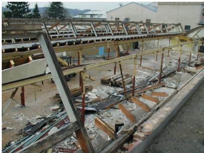
Celková rekonstrukce části střechy kovoprovozu v roce 2002
